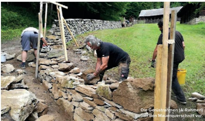
Die Gerüststrahlen (A-Rahmen) geben den Mauerquerschnitt vor.
